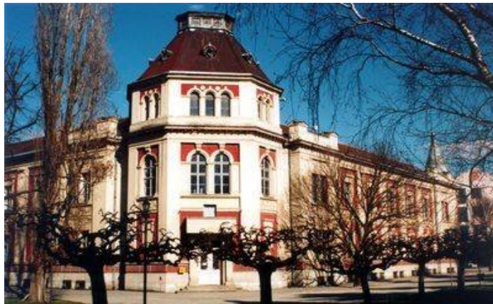
Veliko Grdište – zgrada Skupština Opštine
